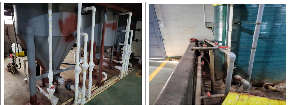
厂内液体物料输送泵、输送管道
